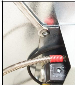
løsne 4 skruer i hjørnene (8)
