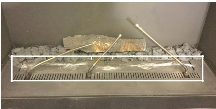
Plasser engle hår langs brenner. Fordel det jevnt over likt som bilde.
