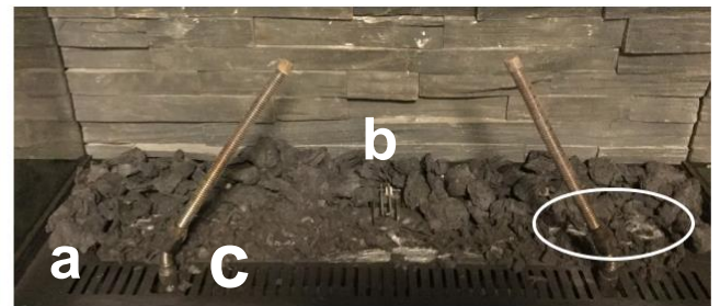
Plasser glass ull på engle hår. (Se detalje a, b, c)
