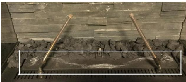
Legg engle hår langs brenner. Fordel jevnt utover som på bildet.
